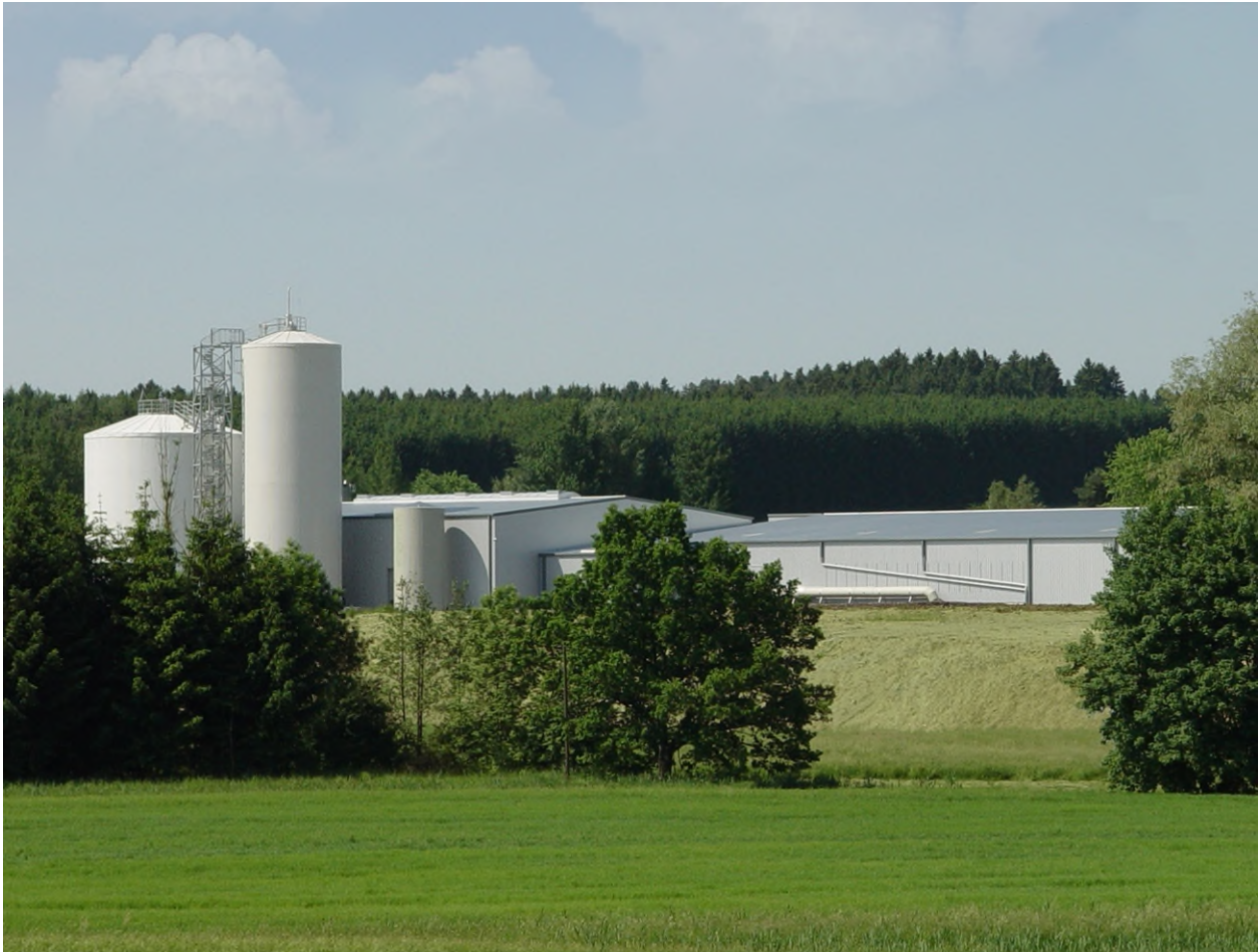
Abb. 16: Bioabfallvergärungsanlage BRS Bioenergie in Deißlingen Quelle: Foto BRS Bioenergie
