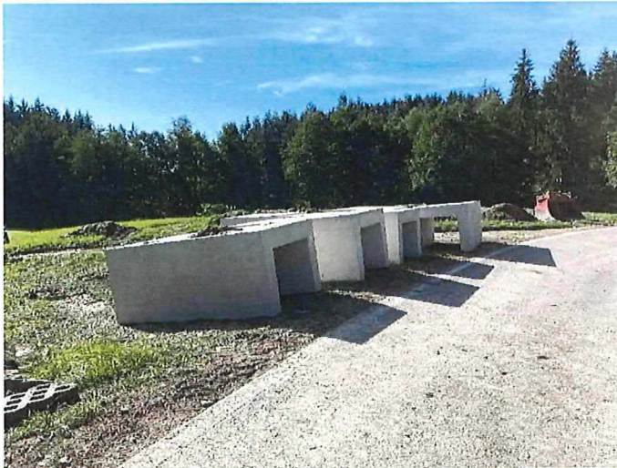
Betonelemente der Amphibientunnel
