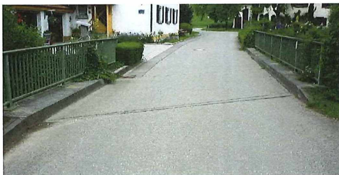
Geländer vor Sanierung
