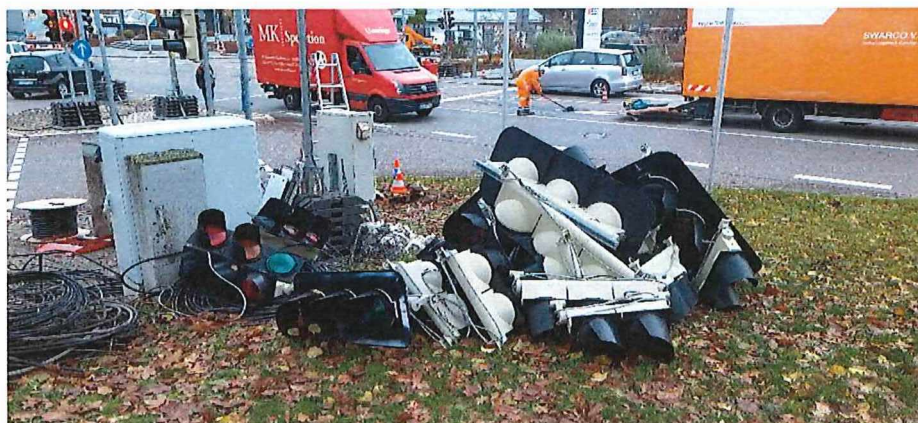
Ausgebaute Lichtsignalgeber
