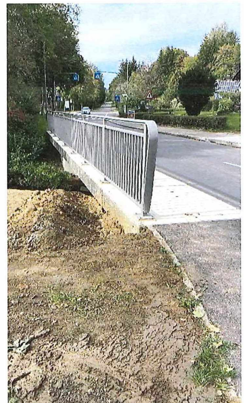
Erneuerung der Brückengeländer
