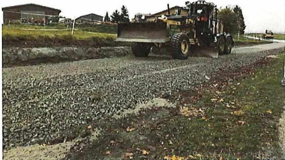
Einbau der Frostschutzschicht
