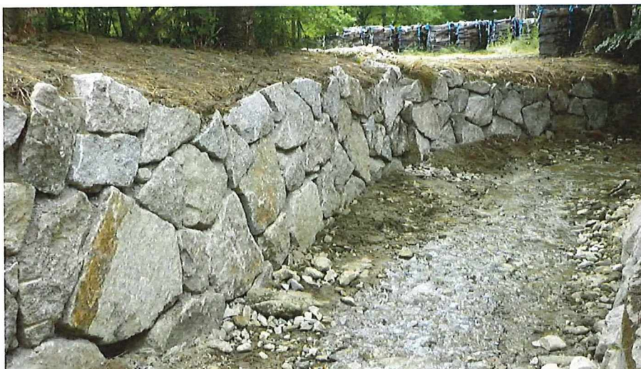
Sanierte Uferböschung
