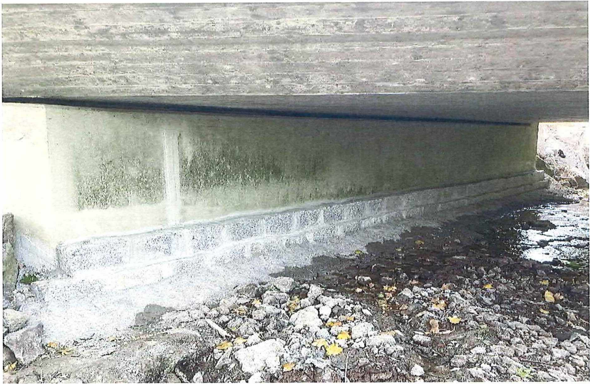
Verstärkung des Kolk-schutzes an den Widerlagern
