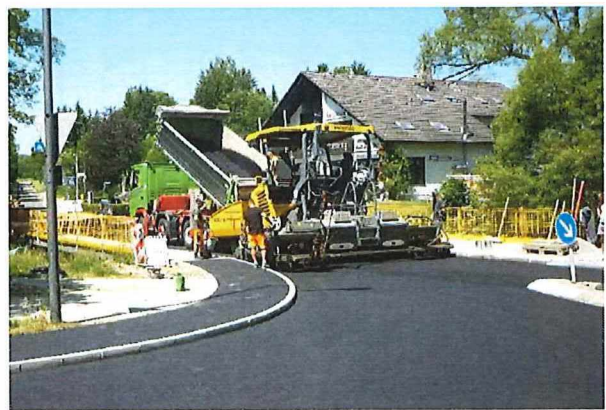
Erneuerung der Asphaltdecke
