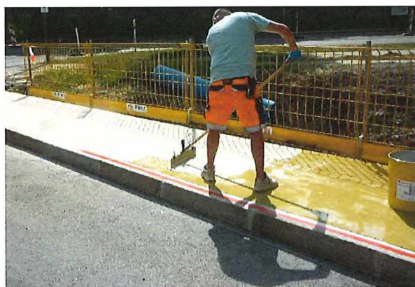
Neue Beschichtung der Gehwege
