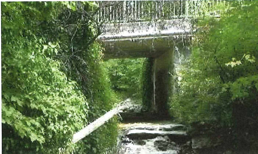
Vor Sanierung der Uferböschung und des Bauwerkes
