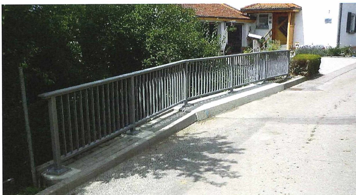
Geländer nach Sanierung
