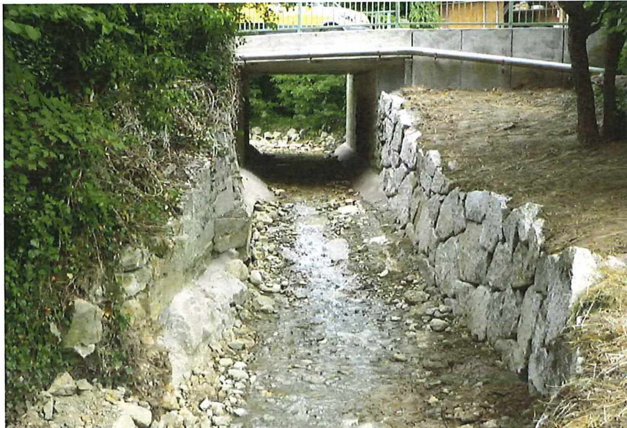
Nach Sanierung der Uferböschung und des Bauwerkes
