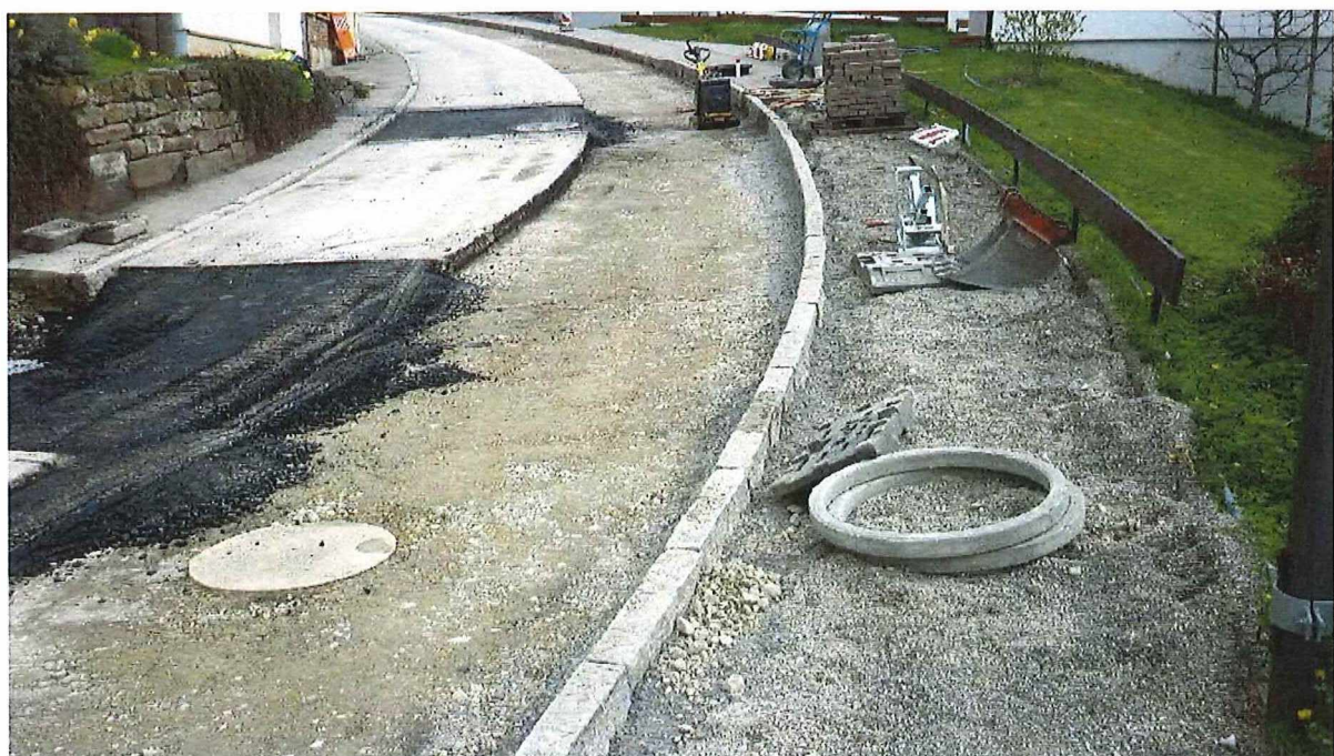
Wasserleitungsgraben nach der Verlegung der Leitung
