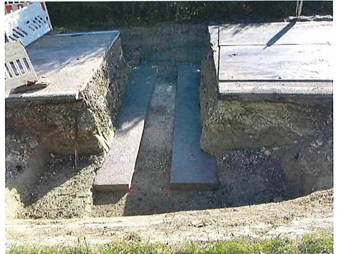
Herstellung von Betonfundamenten für die Amphibientunnel
