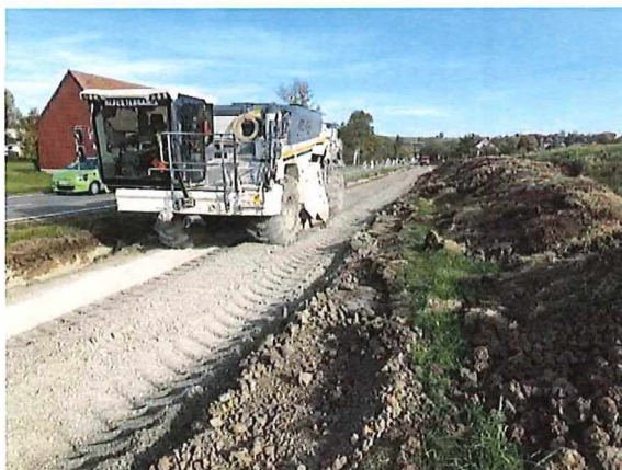
Bodenverbesserung mit Dorosol
