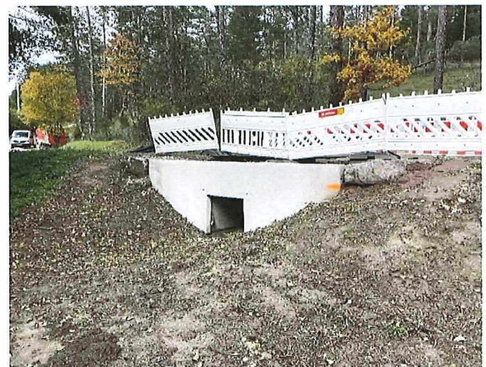
Fertiggestellter Amphibientunnel
