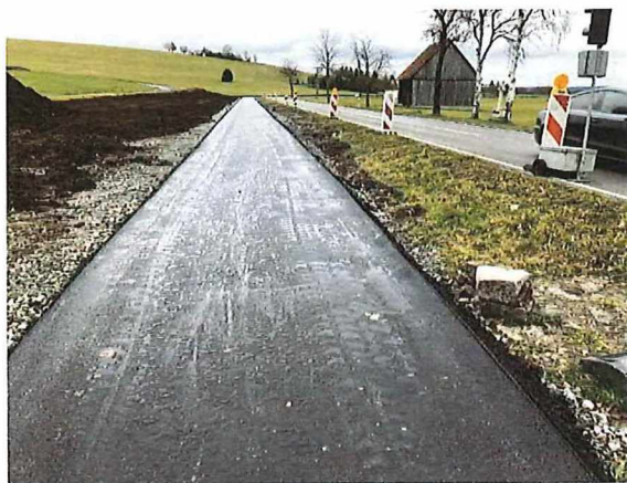
Eingebaute Asphalttrag- und Deckschicht
