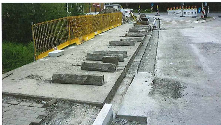
Sanierung der Brückenbordsteine
