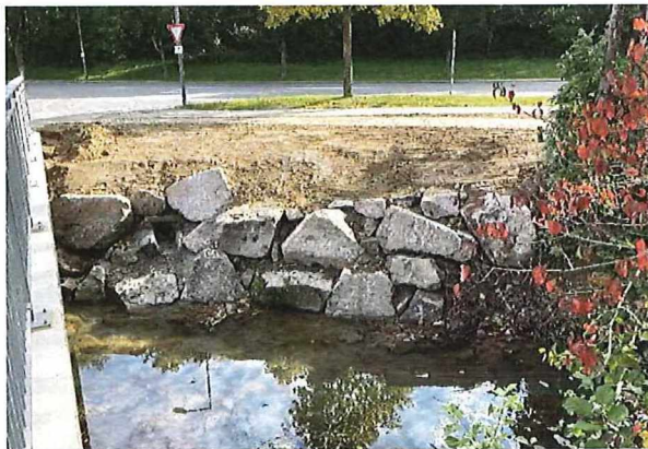
Sanierung Uferböschung
