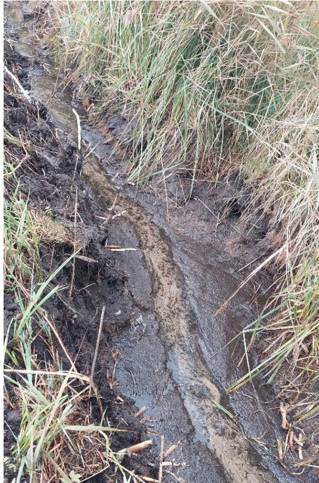
Entnahme der Sohlshalen durch Forst und Baggerbetrieb Jäggle GbR, befreites Bachbett mit beginnender Mäandrierung und sandig-kiesigem Bachbett. (Foto links: Jäggle GbR, Foto rechts: LEV)
