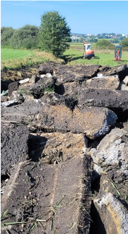
Entnahme der Sohlshalen durch Forst und Baggerbetrieb Jäggle GbR, befreites Bachbett mit beginnender Mäandrierung und sandig-kiesigem Bachbett. (Foto links: Jäggle GbR, Foto rechts: LEV)
